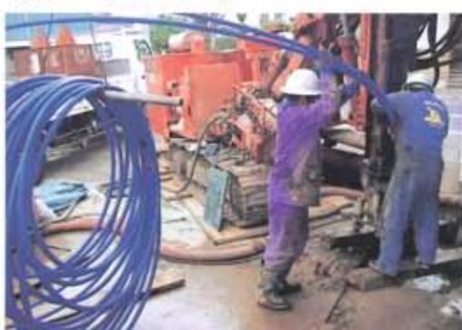
「地中熱ヒートポンプシステム」施工風景
